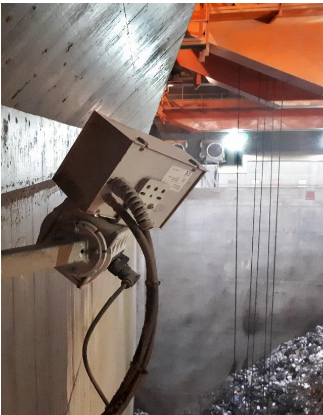
Abb. 2: Die als Twin-Systeme ausgelegten Kameraköpfe sind in speziellen Schutzgehäusen integriert. Zusammen mit den Schwenk-/Neigesystemen bilden sie eine effektive Einheit im 24/7-Betrieb.
